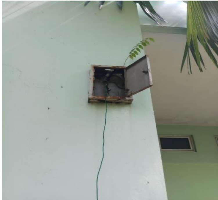
Gambar Bak Kontrol Pada Gedung B
