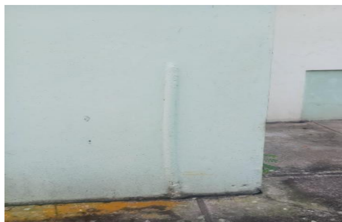
Gambar konduktor penyalur kebawah Gedung B
